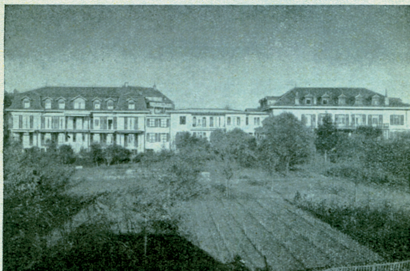
Maison des Vieillards de Chailly, face sud
