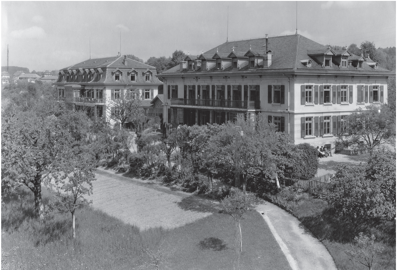
Les deux immeubles de Chailly, reliés par une passerelle, dans les années 1910
